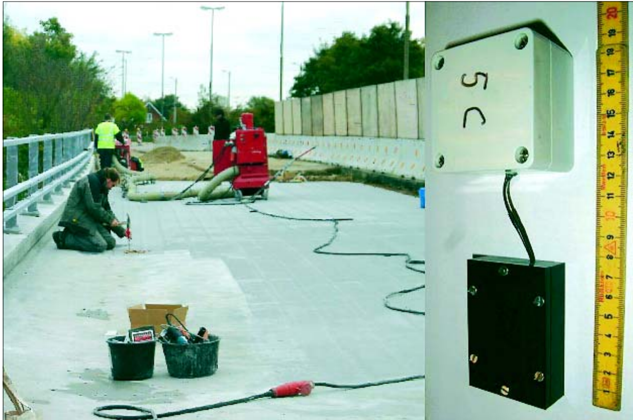
Her klargøres den ene brohalvdel for ny fugtisolering. Til højres ses sensoren (sort kasse) og tilhørende batterikasse.
